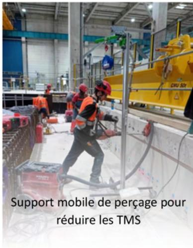
Support mobile de perçage pour réduire les TMS
